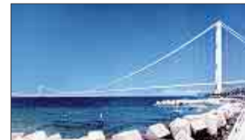
Ponte sullo Stretto Berlusconi: a dicembre partono i lavori
